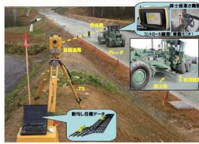
グレーダのマシンコントロール技術(例)
