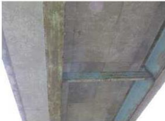
新城館橋 供用年数38年
